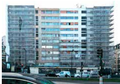
Ci-contre : façade principale du bâtiment donnant sur le boulevard Soult, vue de chantier.
