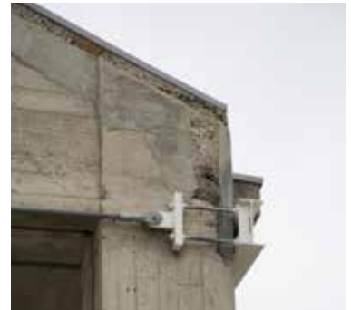
Zooms sur les tirants métalliques discrètement rajoutés.
